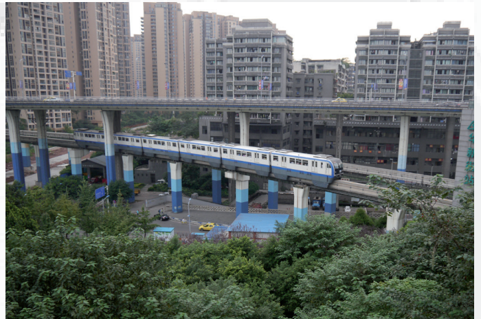
Nord Chongqing nahe des Flusses
