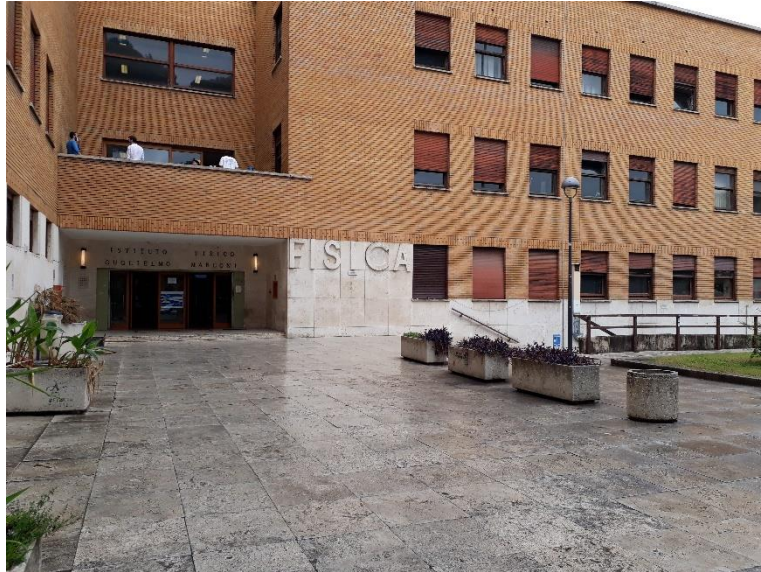
Abbildung 1: Physikgebäude @ La Sapienza
