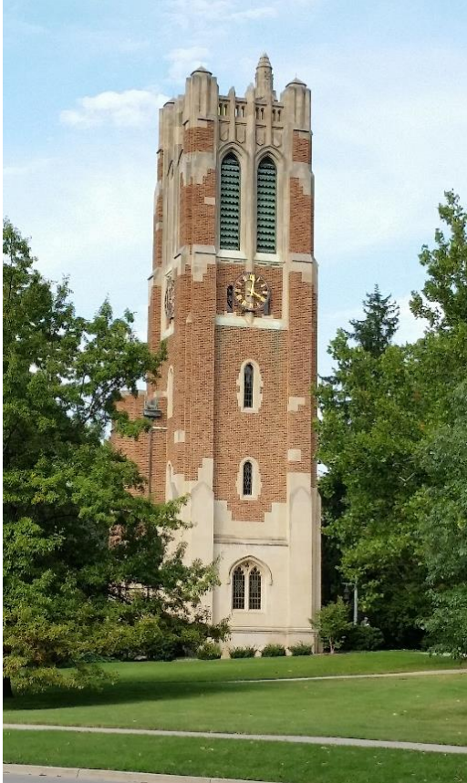
Beaumont Tower auf dem Campus Gelände
