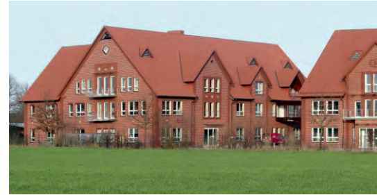
Laserhof: 2001 wurde der Bau des Laserhofes begonnen. Sollte auch er zu klein werden, ist eine Erweiterung möglich.
