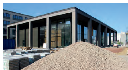
Baustellen- Impression: Vor dem Hörsaalgebäude.
