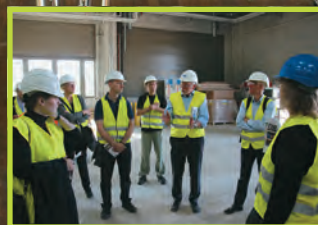
Besuch der Baustelle Garbsen
