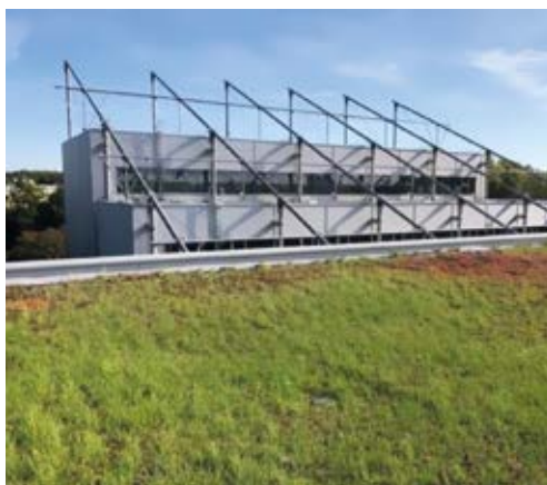
©LUH | Gründach auf dem Unterwassertechnikum in Garbsen
